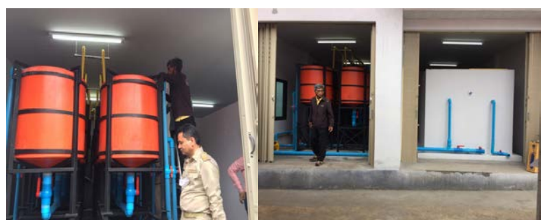
ระบบบำบัดน้ำเสียคลองจาก
